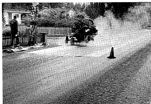
2. Indränkning av fiberduk med bitumenemulsion
